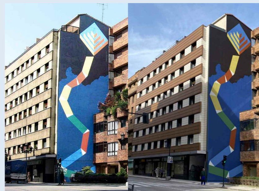
Rehabilitación de fachada mediante Sistema de Fachada ventilada, SATE como base para reproducción de mural y en patios interiores. Calle Fuertes Acevedo. Oviedo. Año 2022.
