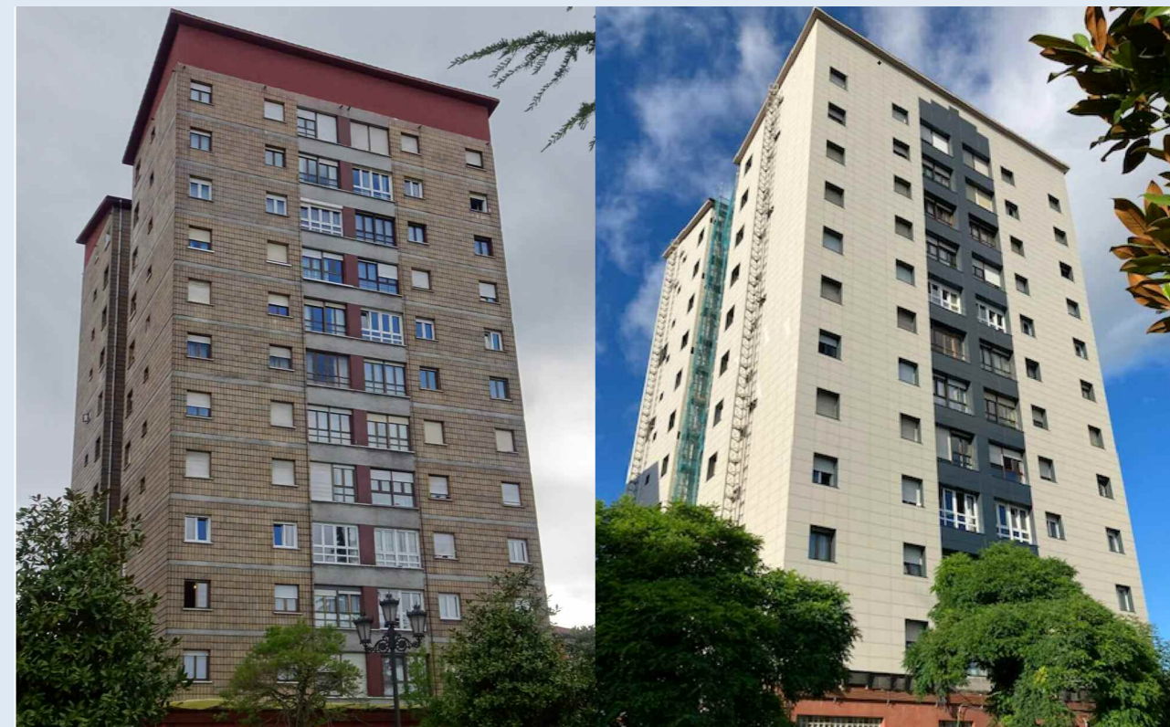
Rehabilitación de fachada mediante sistema de Fachada Ventilada. Calle Velasquita. Oviedo. Año 2023.
