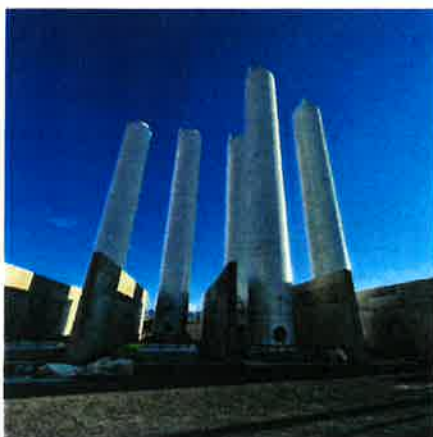
5 Tanques H2- 133 m3 cada uno Presión 60 bar
