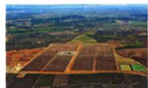
"La Africana" (Córdoba) 50 MW, 164 lazos 1100MWth (~7.5h)
