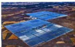
"Andasol-1" (Granada) 50 MW, 156 lazos 1000MWth (~7h)
