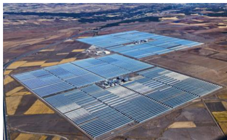
“Andasol-I” (Granada) 50 MW, 156 lazos 1000MWth (~7h)
