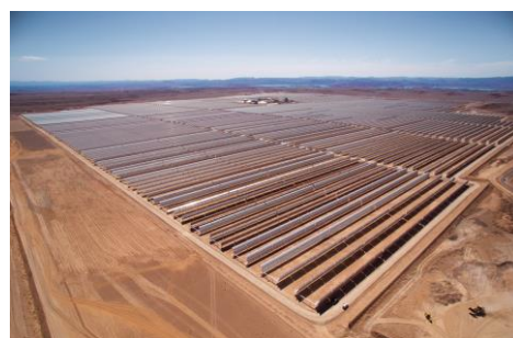
“NOOR-I” (Marruecos) 160 MW, 400 lazos 1300MWth (~3h)
