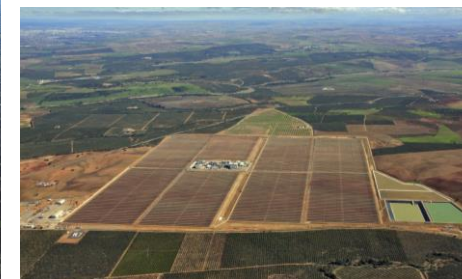
“La Africana” (Córdoba) 50 MW, 164 lazos 1100MWth (~7.5h)
